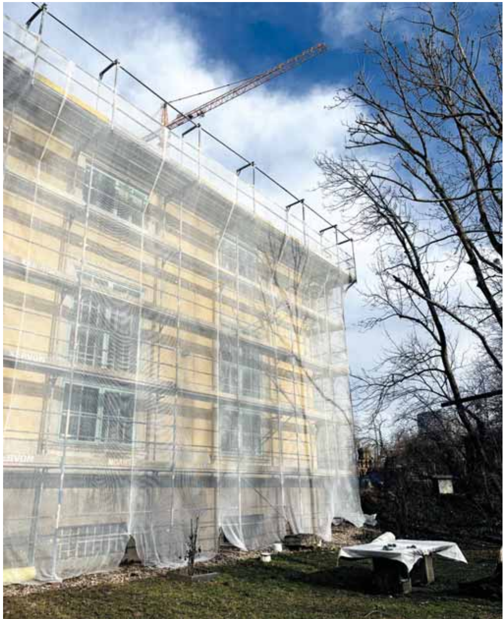
Sanierung der Praterateliers, Ansicht Nordpavillon
